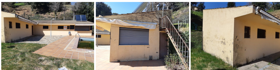
Façanes exteriors dels vestidors: longitudinals i testeres
