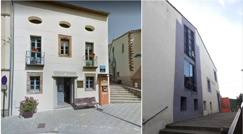
IMATGES DE L'ESTAT ACTUAL DE LES FAÇANES
