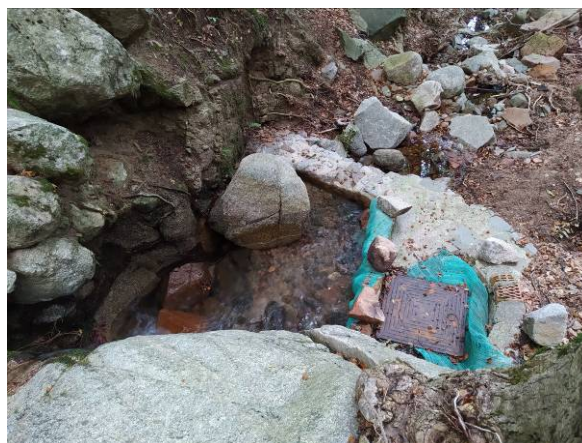
Foto 7.4 – Vista posterior captació C4 en data 29/09/2020
