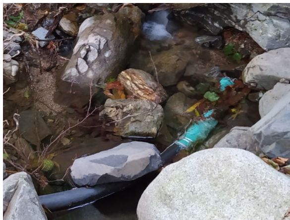
Foto 4.2 – Detall sistema de captació a C2.2 en data 29/09/2020
