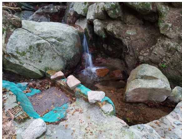
Foto 7.2 – Vista frontal captació C4 en data 29/09/2020
