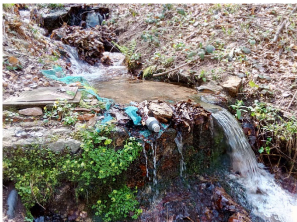
Foto 8.1 – Vista frontal captació C5 en data 19/04/2018
