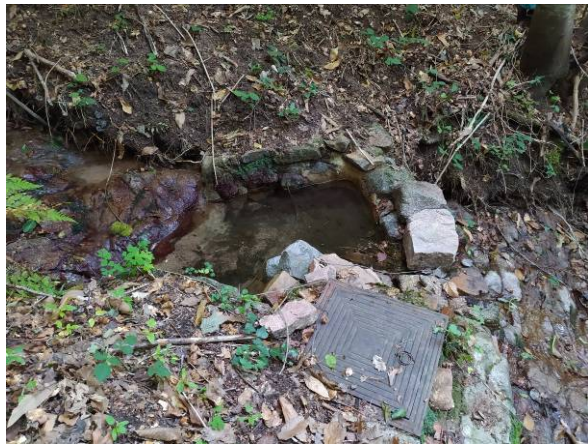
Foto 8.4 – Vista lateral captació C5 en data 29/09/2020
