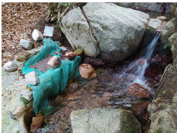
Foto 7.3 – Arqueta captació C4 en data 29/09/2020
