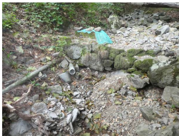
Foto 5.4 – Canonada de fibrociment a sortida d'arqueta
