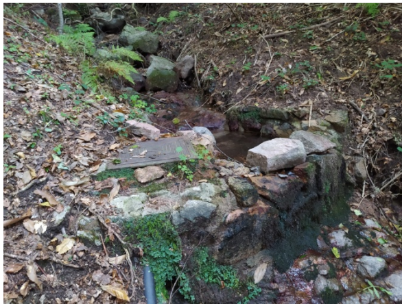
Foto 8.3 – Vista frontal captació C5 en data 29/09/2020
