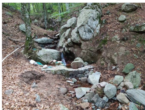
Foto 7.5 – Vista frontal captació C4 en data 29/09/2020
