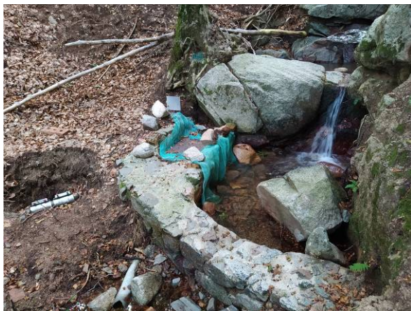
Foto 7.1 – Vista frontal captació C4 en data 29/09/2020
