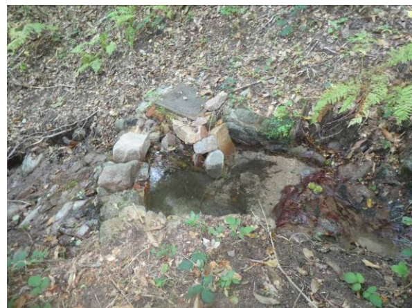
Foto 8.6 – Vista lateral captació C5 en data 29/09/2020
