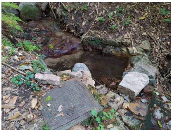
Foto 8.5 – Vista arqueta captació C5 en data 29/09/2020
