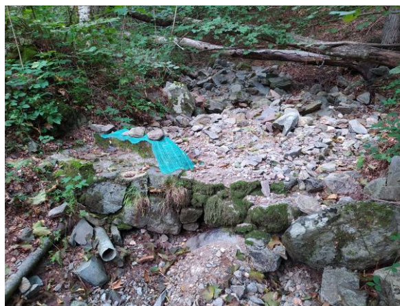
Foto 5.2 – Vista frontal captació C3.1 en data 29/09/2020
