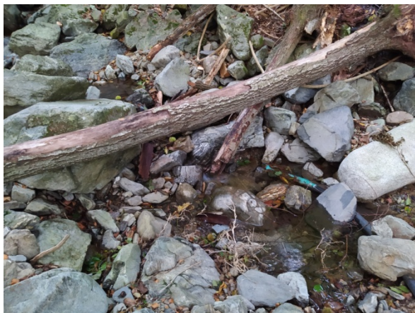
Foto 4.1 – Vista frontal captació C2.2 en data 29/09/2020
