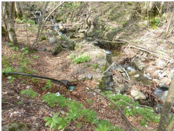
Foto 3.1 – Vista lateral captació C2.1 en data 19/04/2018
