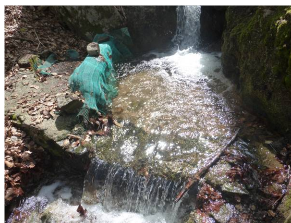
Foto 7.6 – Vista frontal captació C4 en data 19/04/2018
