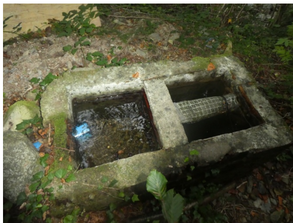
Foto 2.6 – Detall arqueta recollida d'aigües en data 29/09/2020
